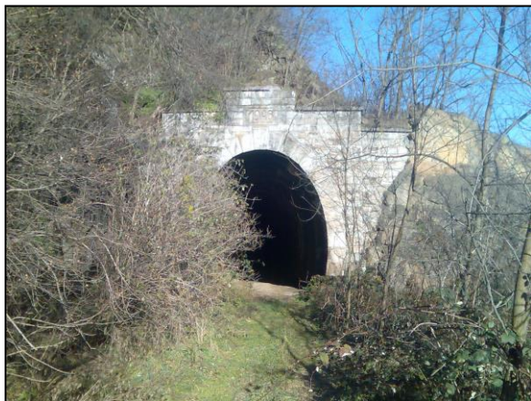
Obr. č. 6 – Železničný tunel v obci Píla
