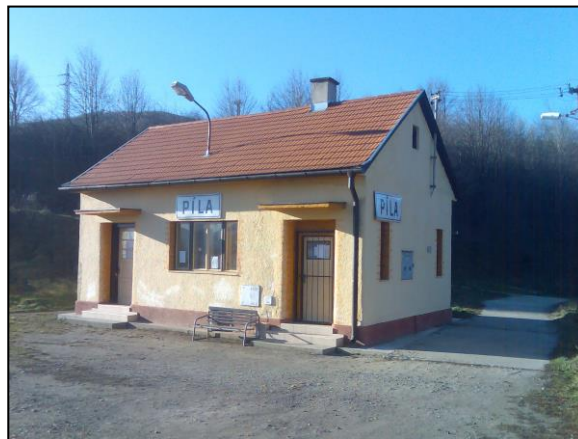
Obr. č. 7 – Budova železničnej stanice v obci Píla
